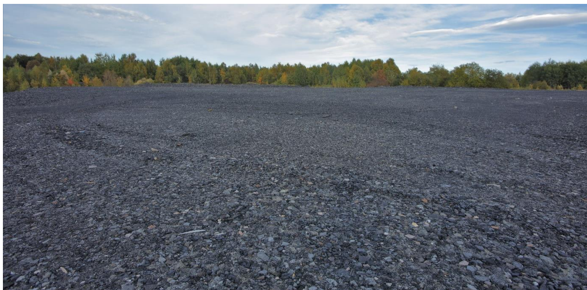
Fot. 8. Rozległy, utwardzony kruszywem plac, stanowiący właściwe miejsce planowanej budowy.
