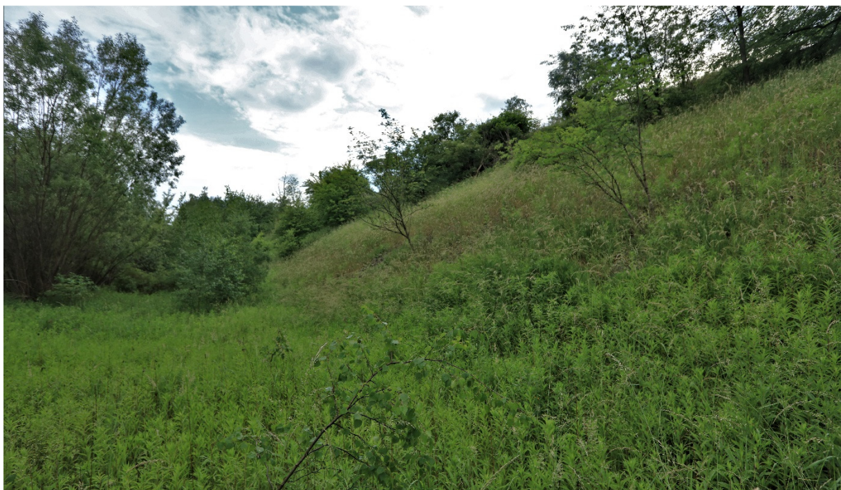
Fot. 5. Nasyp linii kolejowej wyznaczający zachodnią granicę terenu inwestycji.
